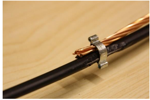
Maadoituskupari on kytketty yhteen jatkoskoteloon tulevista talokaapeleista
