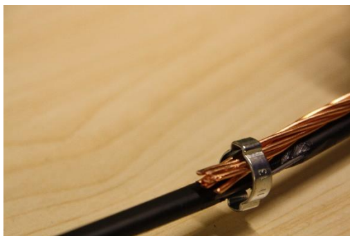
Asettele letkunkiristin sellaiseen asentoon, että kaapelin teräslangat eivät tule sen korvakkeiden kohdalle. Litistä maadoituskuparin päätä ja työnnä se sitten liittimen ja kaapelin väliin.
