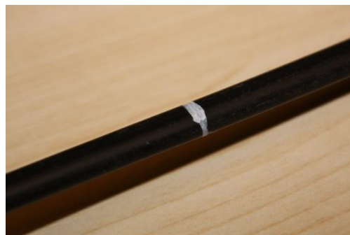
Merkitse maadoituksen paikka yhteen jatkokseen tulevista kaapeleista, jossa on teräksiset vetolangat
